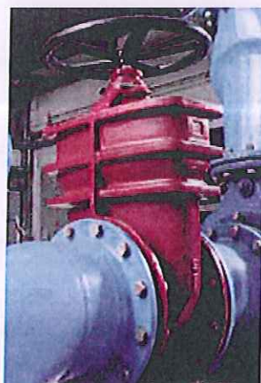
Zakłady wodociągowe Schwetzingen, Niemcy 10 zasuw klinowych VAG BETA® 200
